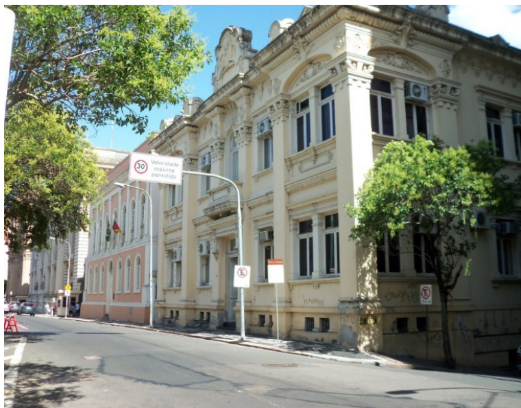
Figura 3 – Prédio da antiga Escola Complementar (1921-1936)
